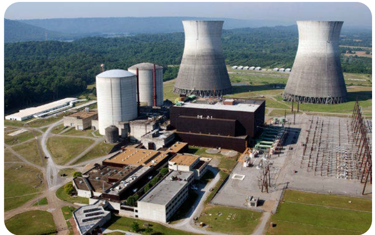
The unfinished Bellefonte nuclear plant. Photo: Wikimedia Commons
